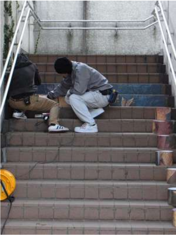
写真2は蹴込みの表示作業中（2段目までが出来たところ）。
